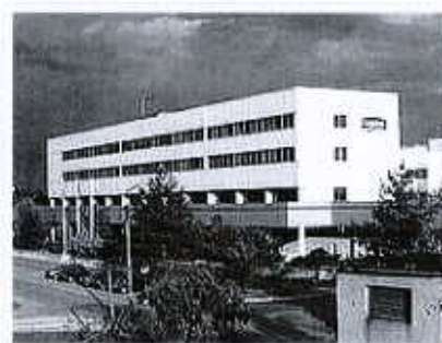
Usine Danone à Bieruń, Pologne
